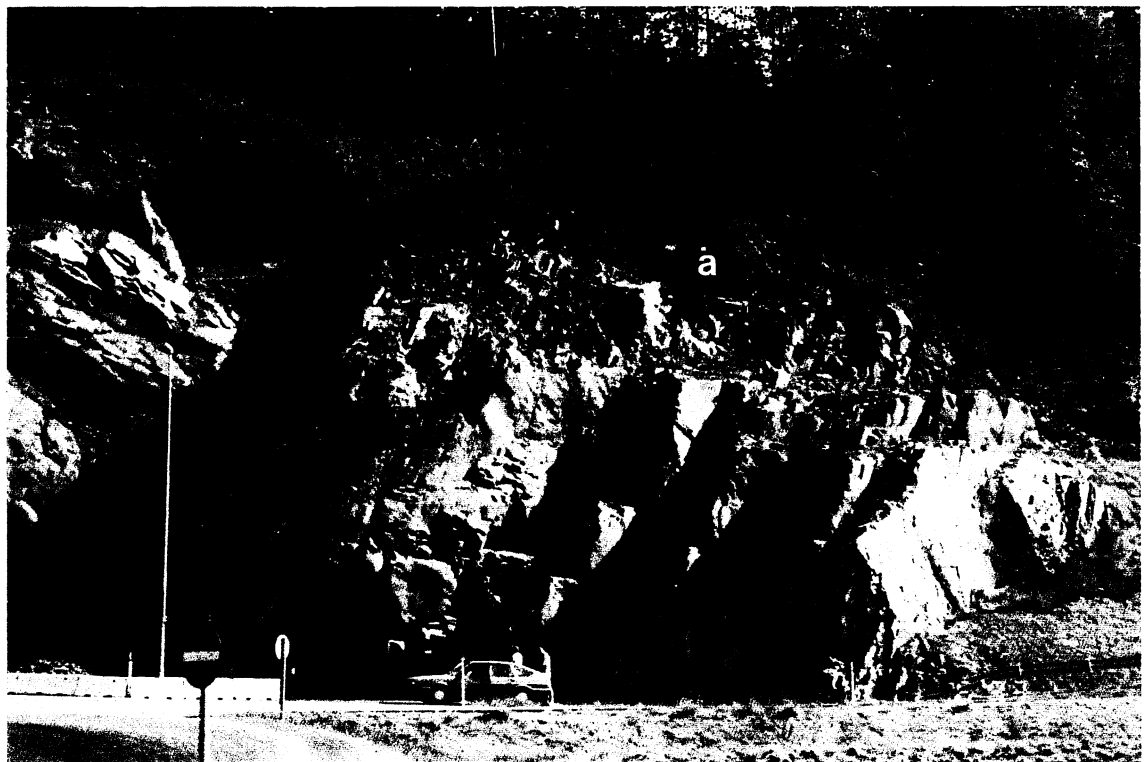
FOTO 5 Sørvestligste del av fjellskjæringen, over G/S-vegen.
