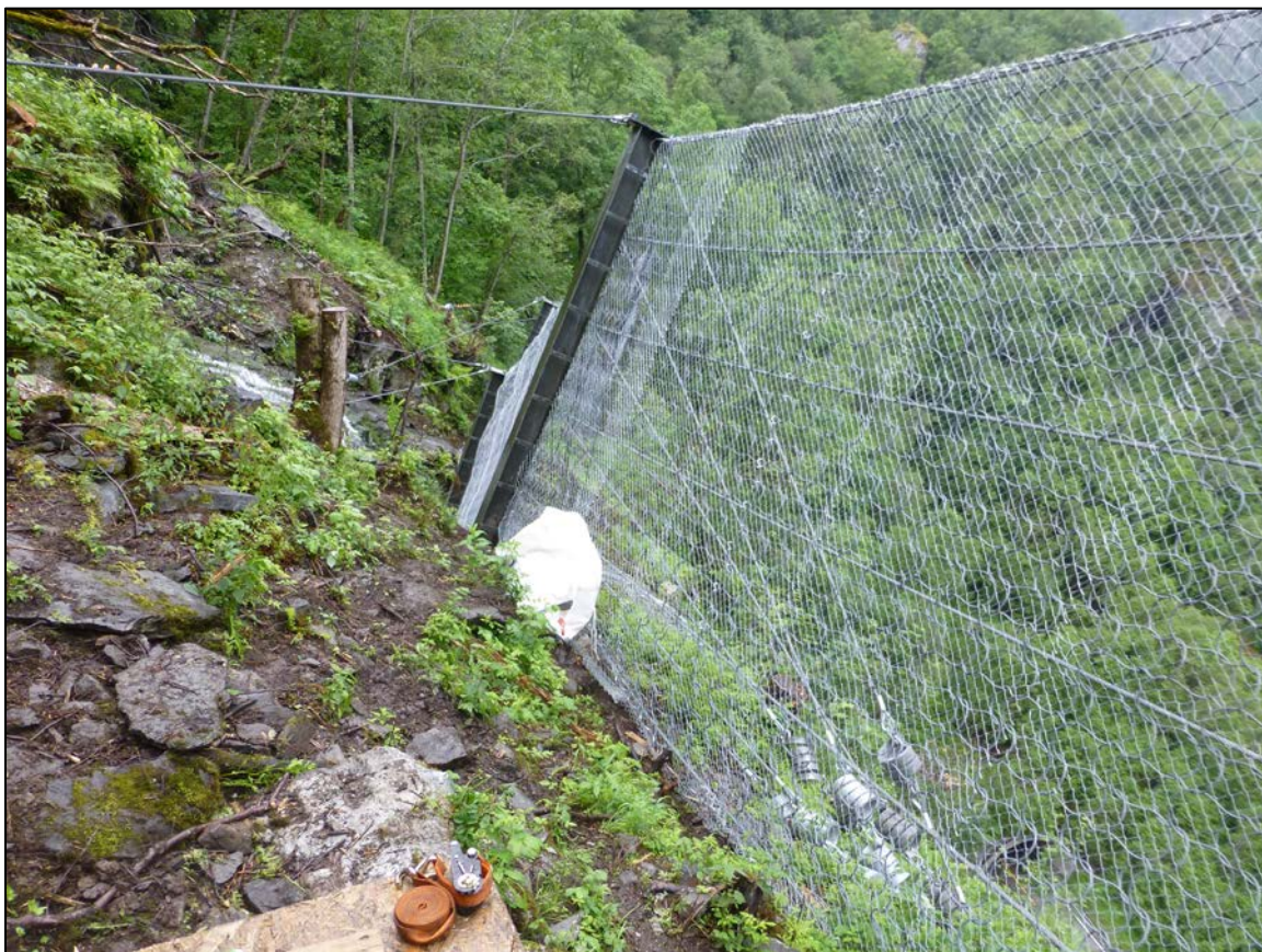
Figur 3. Nye paneler og noen nye bremseelement.
