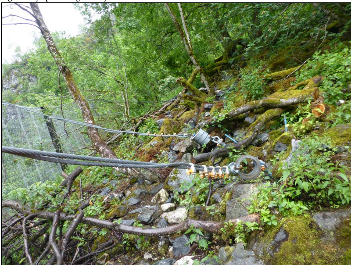
Figur 4. Korrekt monterte wireklemmer. Oransje spray er for å markere at wireklemmene er prøvetrukket. Noe spiss vinkel mellom barduner og Ischebeck 40/16 for forankring på disse to bardunene.
