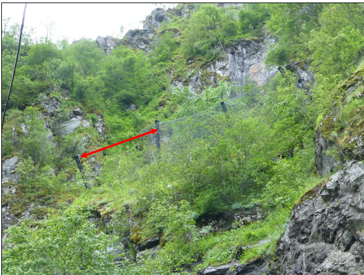
Figur 1. Fanggjærde lengst mot sør. Her skal et panel byttes i løpet av uke 26, 2017.
