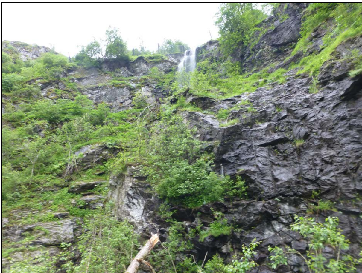
Figur 7. Større trær og busker i fremkant av gjerdet må hugges for å gi sikt til inspeksjon av gjerdet fra vegen. Området mellom gjerdet og vegen bør gås over med spettersk og kontroll av løse blokker/ parti.
