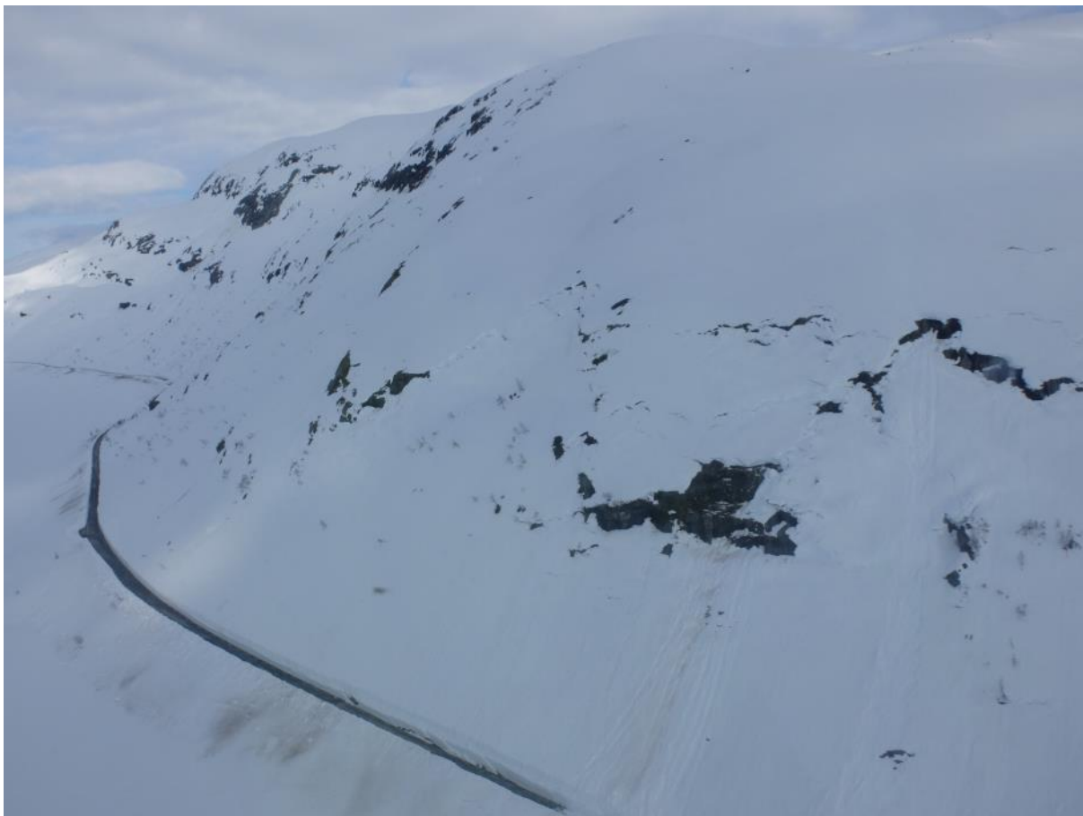
Figur 7 - Snildaneshola 5.5.2015. Tjukt og tungt snødekke fører til mykje sig og oppsprekking, samt mange skred i vegen
