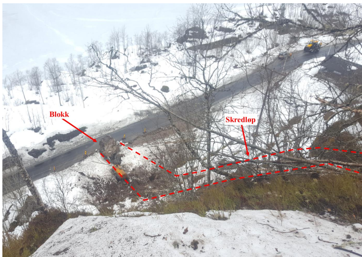
Figur 6: Nedre del av skredløpet tatt frå berghylle på oppsida av vegen.
