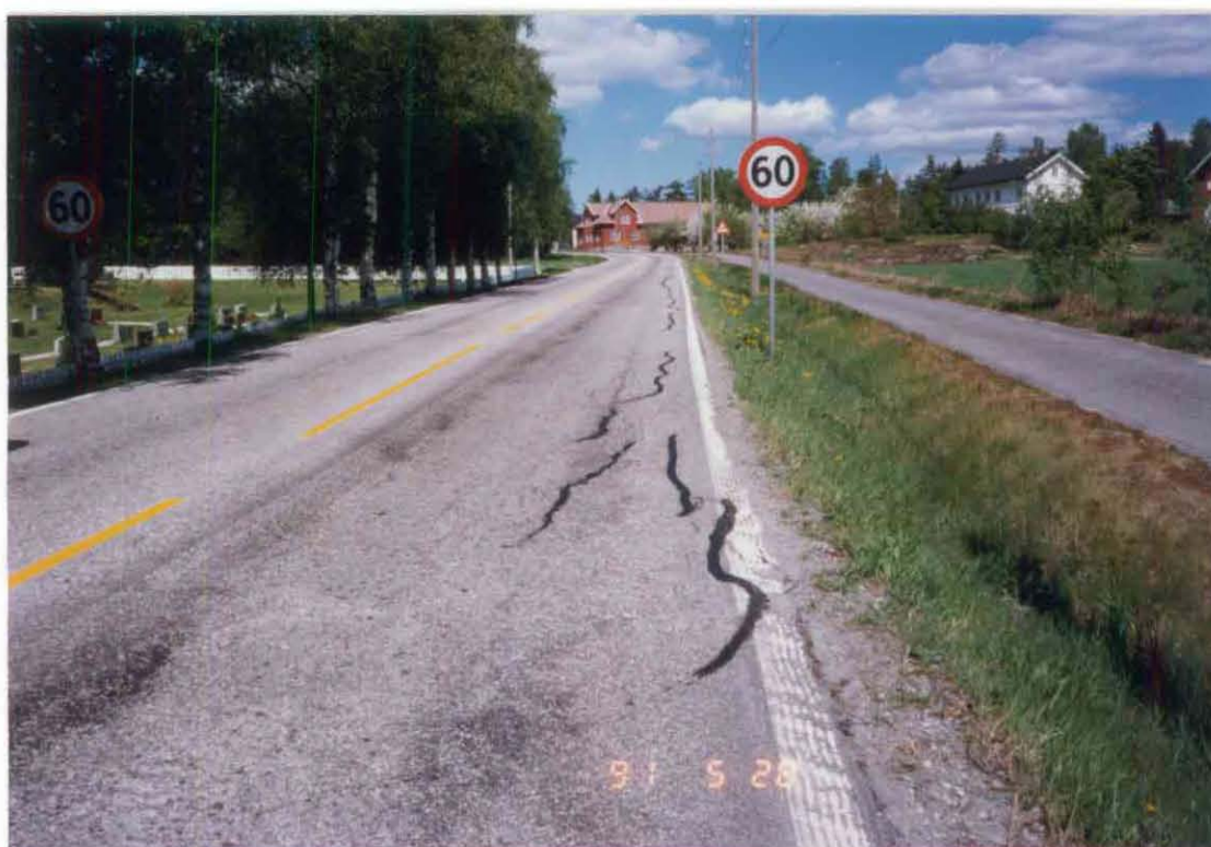
LANGSGÅENDE SPREKKER I HØYRE VEGBANE, REGISTRERT VÅREN '91. SETT MED KM. RETN. FELT UTEN "PAVE-PREP"
