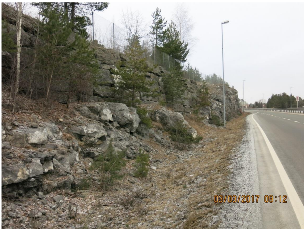
Bilde 7(over): Vegetasjons rensk nedenfor tilstøtende steinmur og bergskjæring i starten av avkjøringen mot Shell stasjonen. På bildet sett i retning mot Hønefoss.
