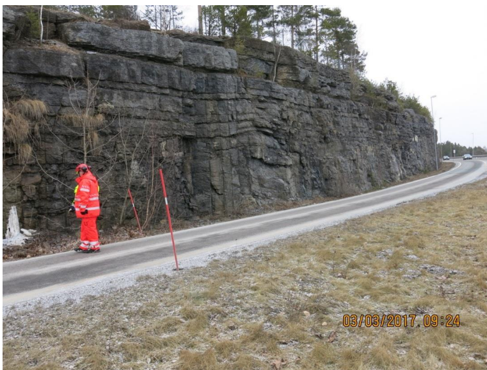
Bilde 2(over) Samme bergskjæring som bilde 1; men sett i retning mot Hønefoss. Utføre vegetasjons rensk + spett rensk.
