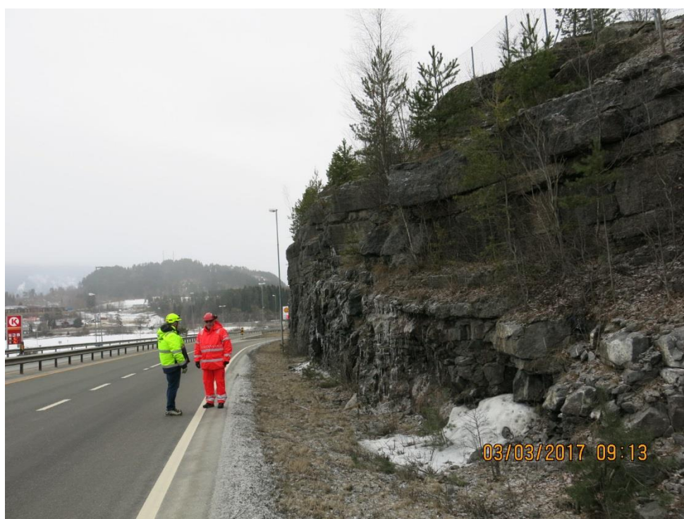
Bilde 4(over): Vegetasjons rensk + spett rensk mellom m 6131 – 6247 Hp53 ved avkjøring mot Shell stasjonen. E16 ved Vik.
