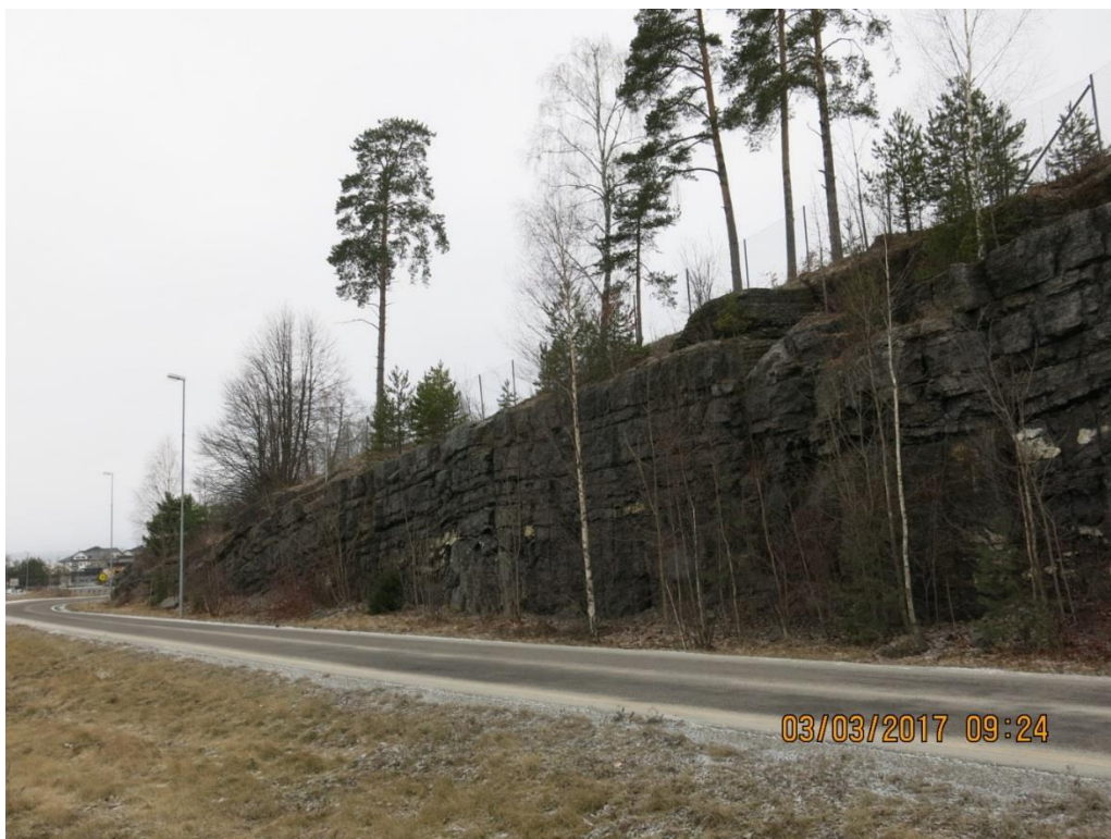
Bilde 5(over): Vegetasjons rensk i tilstøtende bergskjæring i retning mot Shell stasjonen.
