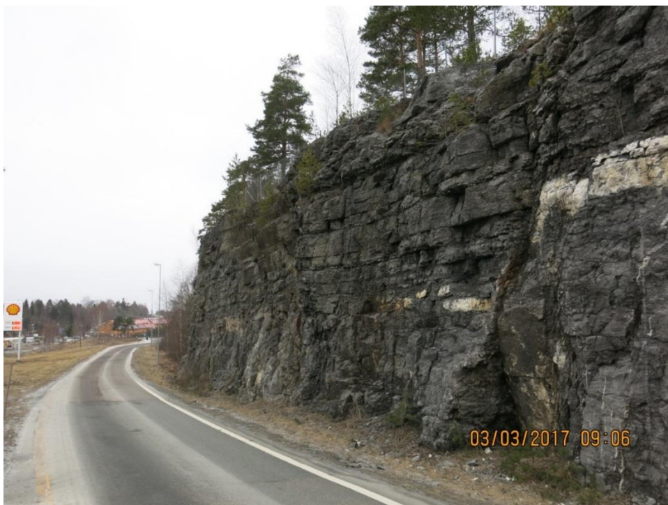
Bilde 1(over): Deler av bergskjæringa mellom m 6131 – 6247 Hp 53 på avkjøringen mot Shell stasjonen ved E16 Vik. Utføre vegetasjons rensk + spett rensk.
