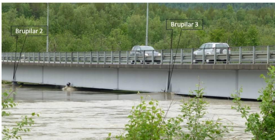
Figur 6. Bilde tatt 15.07.2012 kl 12:24. Vannstanden ved pilar 2 (lengst til venstre i bilden) ser ut til å gå akkurat under brupilaren som har en kote på 5,27 og rett under underkant bru (hvis man bortser fra den åpenbære oppstuingen rundt pilar 3) ved pilar 3 som har en kote høyde på 5,27 m – vst kote vurderes til ca 5,2 m. Foto: Hallvard Berg, NVE
