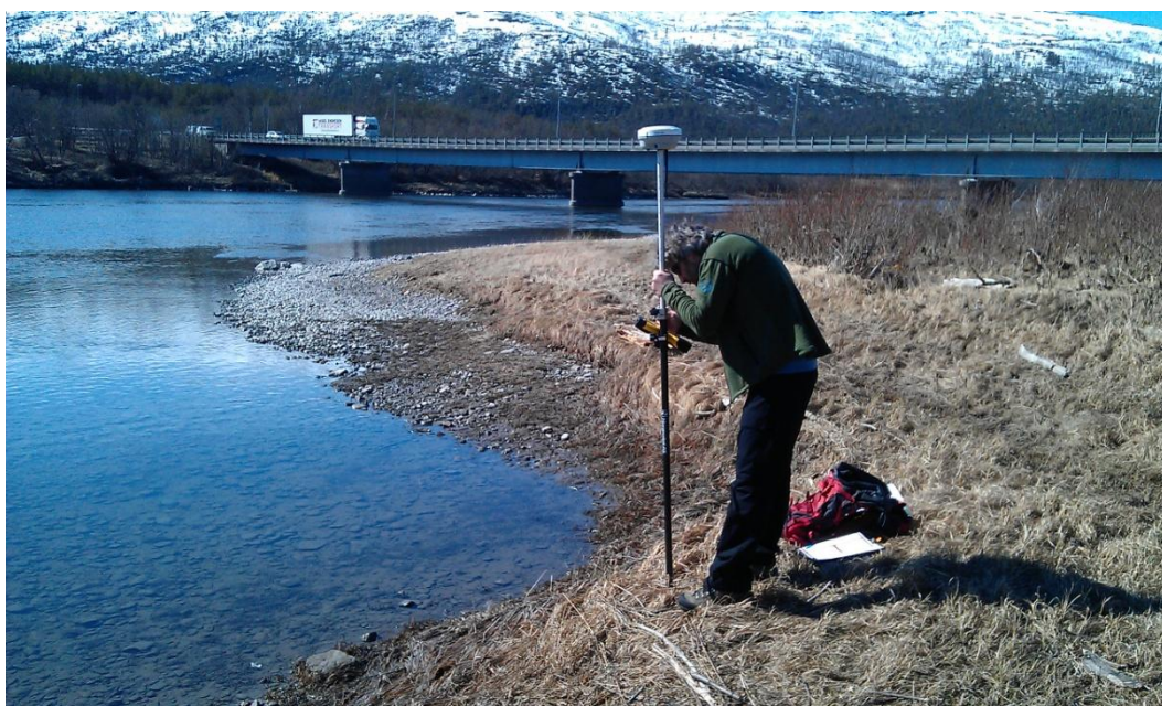
Figur 1. E6 Målselv bru, sett fra oppstrøms side. Brupilarane fra venstre er nummerert: en, to og tre (pilar nummer fire er rett utanfor bildet). (Foto: Seija Stenius, NVE)
