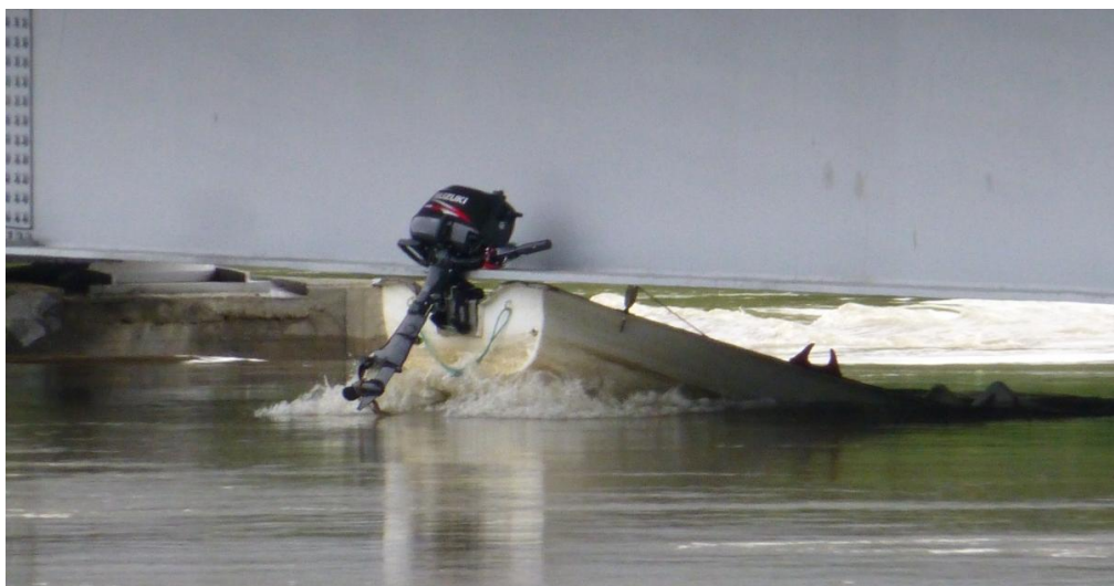
Figur 8. Bilde tatt kl 18:49. Underkant kjørebane ved brupilar 2 (som vises i bilden) er på kote 5,62, overkant brupilar kote 5,27 og underkant brupilar (som er under den aktuelle vannstande) er på kote 4,82. Vannstanden er dermed mellom kote 5,27 og 4,82. Vannstanden vurderes her til kote ca 5. Foto: Statens vegvesen.
