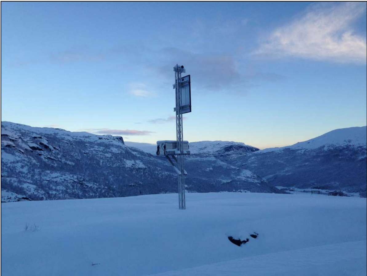
Figur 4. Kamera og brenselcelle slik det står montert vinteren 2016/2017 ved Fv 53 Tyin – Årdal. Det er her valgt en gittermast for å få brenselcellen over snødekket, og for å kunne ha en integrert løsning med solcellepanel som ekstra strømforsyning. Kameraet er plassert i toppen av masten, over den høyden som brøytebil kaster snø.
