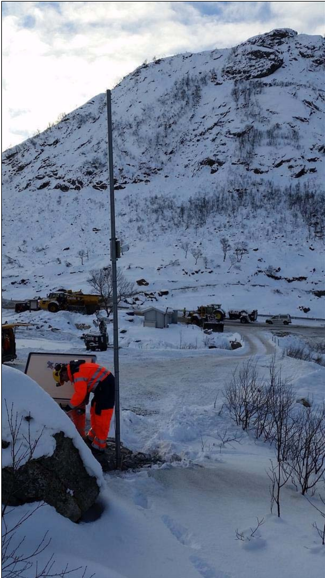
Figur 1. Kamera og brenselcelle under montering ved E39 i Romarheimsdalen vinteren 2015/2016. (Foto John Børre Veum).
