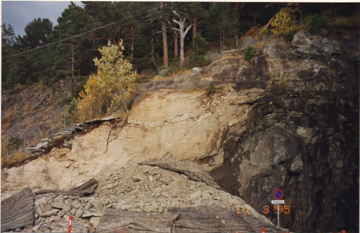
Etter sprenging glei ein del av skjeringa ut.
