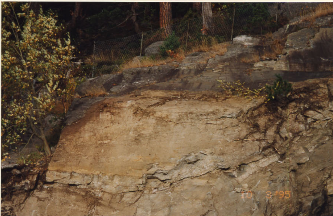
Eit laust flak må boltast med med til saman 12 boltar.
