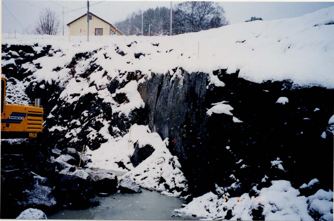
Fundamentet kan plasserast frå profil 60 og sørover (mot høgre). Profil 60 er markert med ei trestikke oppe i snøen litt til høgre for midta på biletet. Ferdig veg kjem i høgde med raudt kryss på skjeringsveggen.
