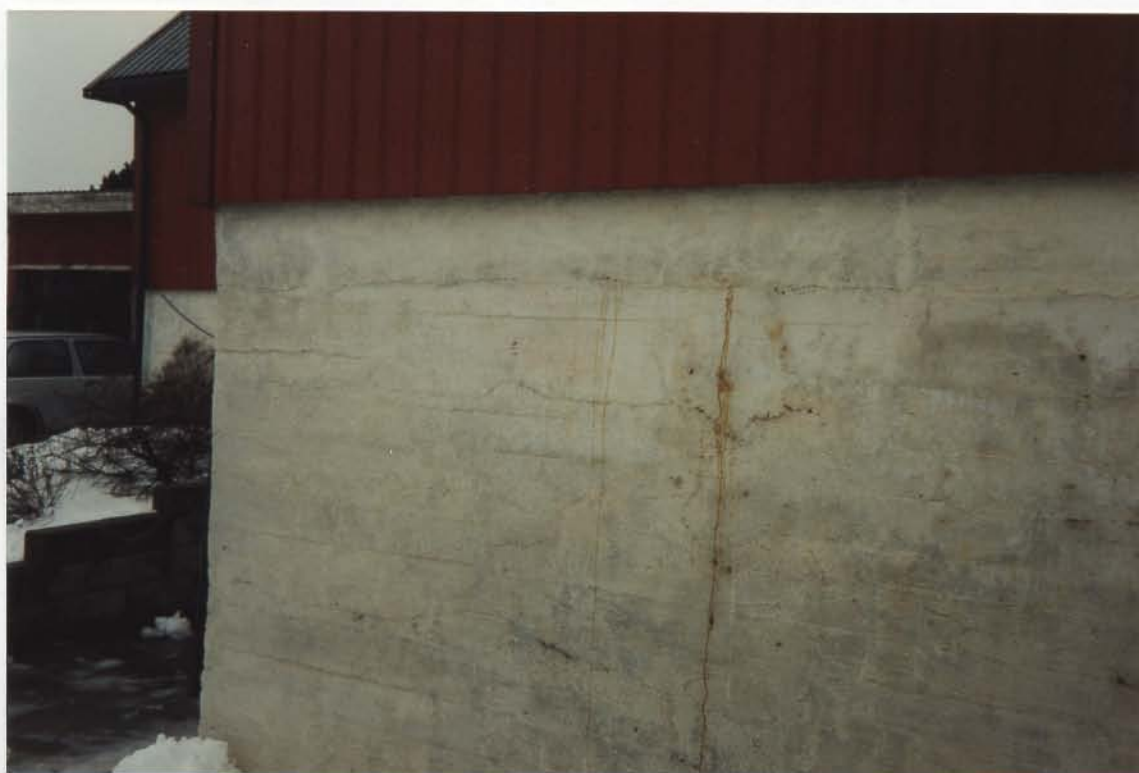
BISGÅRDEN: SPREKKER I GJØDSELKJELLERMUR.
