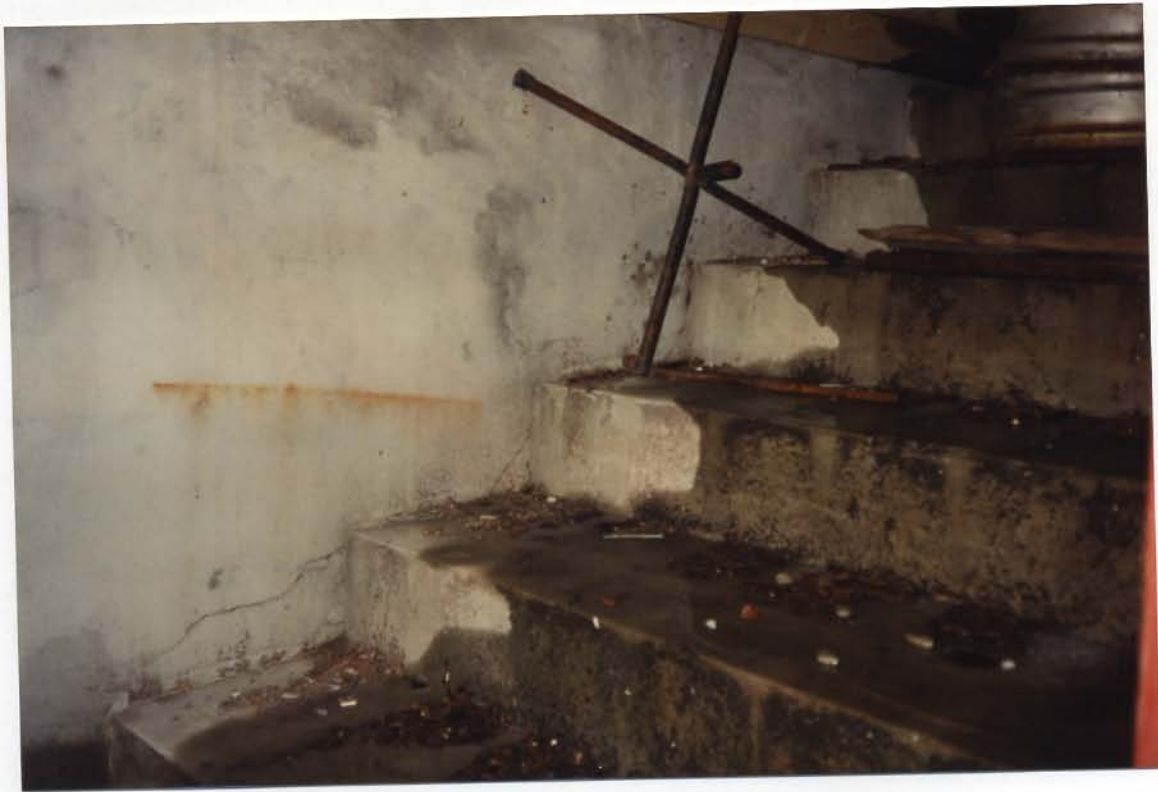
RØSAND: TRAPP UNDER TERRASSE.
