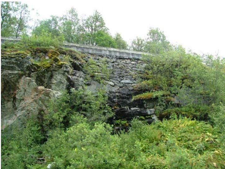
Litt lengre oppe langs fylkesvegen, er det ein svært steil tørrmur der det er brukt liten stein. Det ser ut til at betongrekkverket er pressa litt ut og har teke med seg øvste steinrada. Også her fluktar muren med bergoverflata nedanfor.
