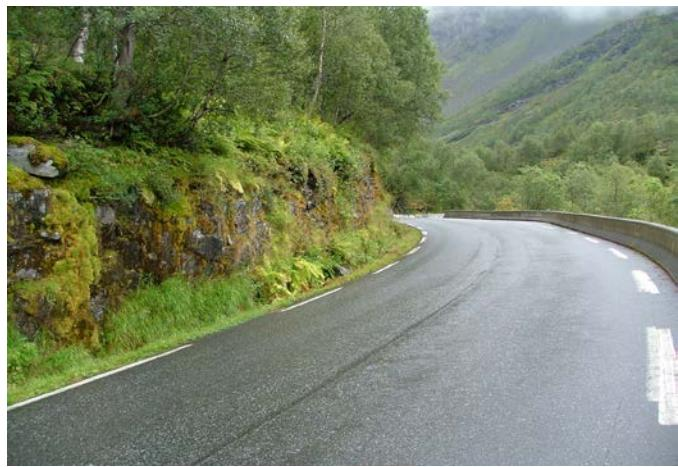
På problempartiet ligg vegen i utkurve og det er 4 – 5 m høg bergskjering på innsida av vegen. Bak skjeringstoppen er det moderat terrenghelling (1:3,5 til 1:2,5). Det blir derfor foreslått flytte vegen inn. På vedlagt kart er det skissert ein indre vegkant med radius 125 m. Eksisterande kurve har radius på ca. 100 m.
