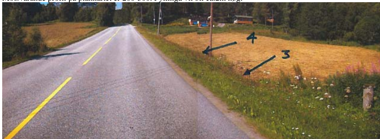
Bilete fra NVDB (hp02-km6,3) som viser strekninga opp mot campingplass, i retning Molde. Profilnr. på plankartet er 0-150. Antek ca. 2meter fylling.
