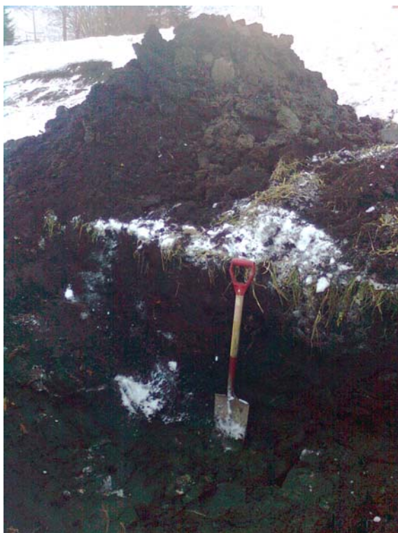
Foto som viser steinsatt dreneringsgrøft (sjakt 1), og metertjukt torvlag (sjakt3)
