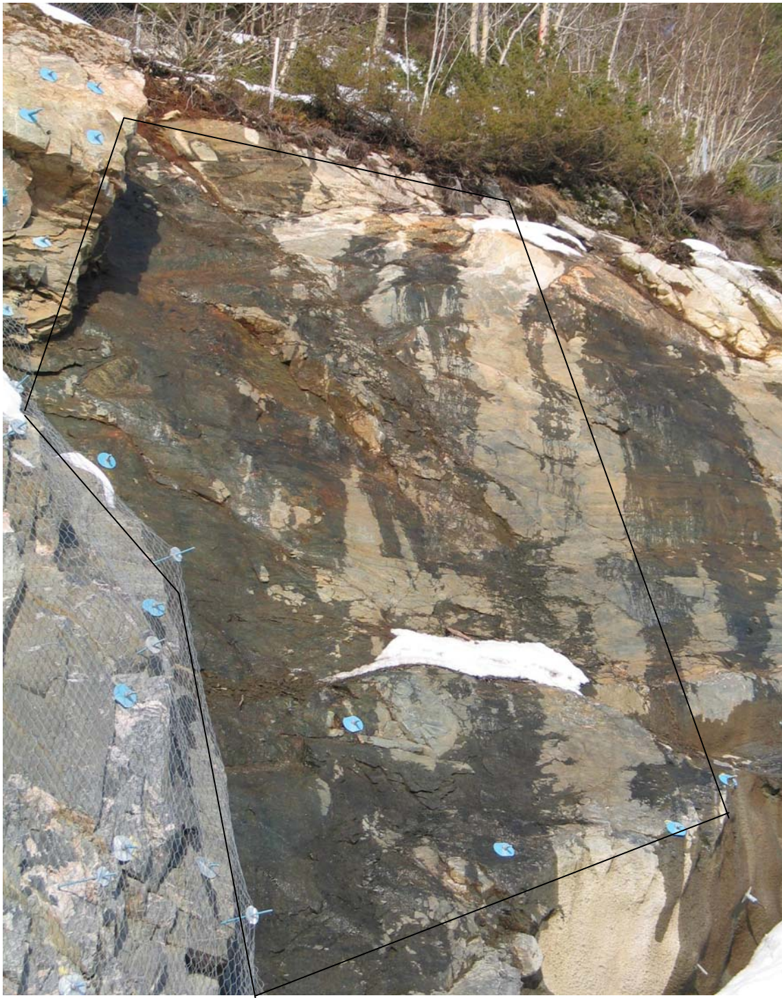
Bilde 2: Anbefalt løsning er å montere nett helt opp slik som antydnet med svarte streker på bildet.
