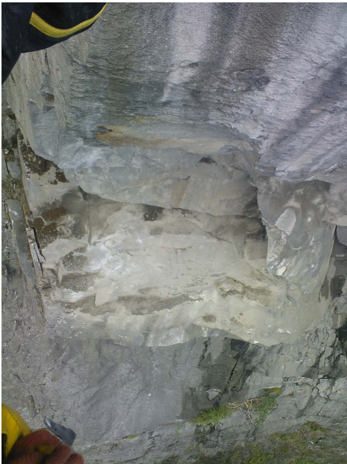
Figur 6: C5-4, etter sprengning (foto: Betongrenovering)
