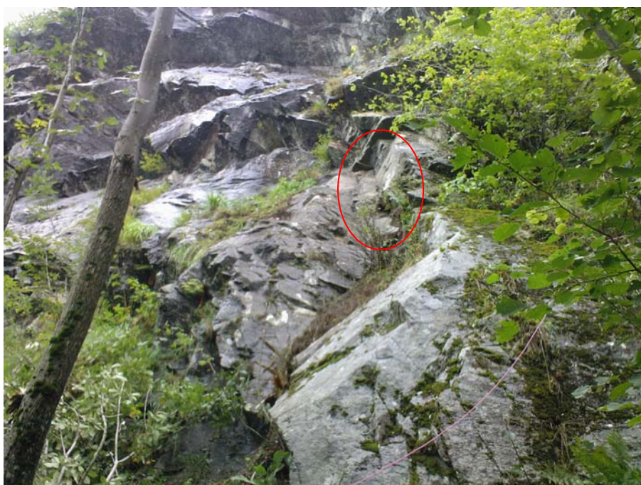
Figur 8: C6-1, etter sprengning (foto: Betongrenovering)
