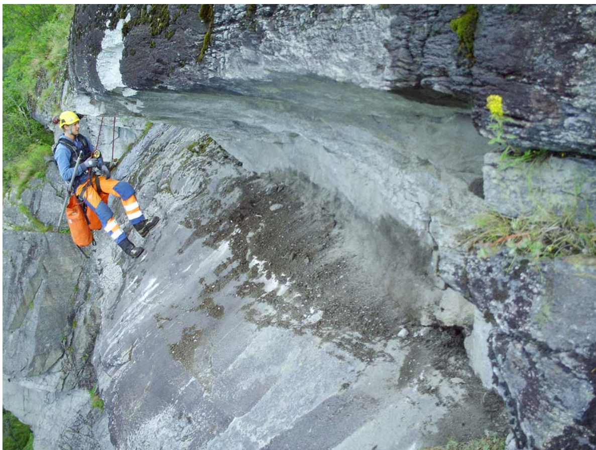
Figur 4: C5-1, ferdig utsprengt(foto: Betongrenovering)
