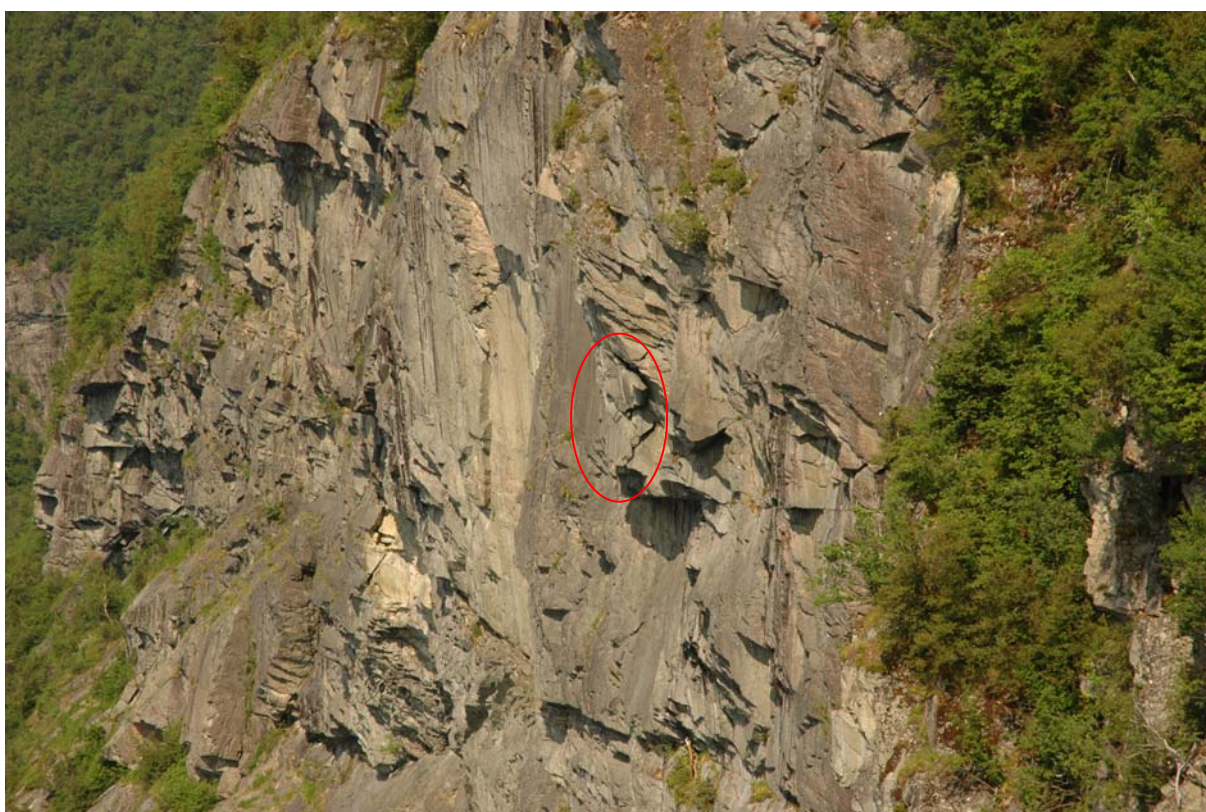
Figur 5: C5-4, før sprengning (foto: Multiconsult)
