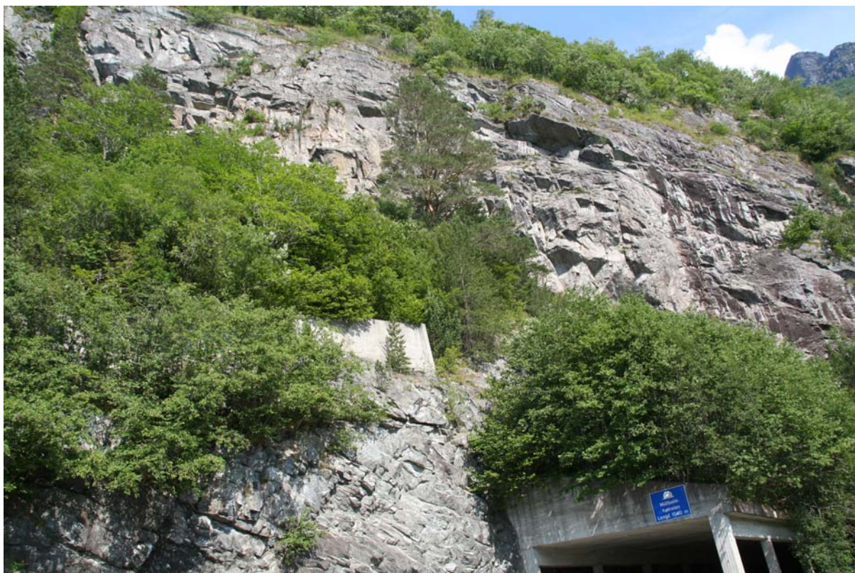
Figur 1: Denne skrenten over det nordre påhugget på Midtbekktunnelen ble rensket av klatrelag fra Betongrenovering.
