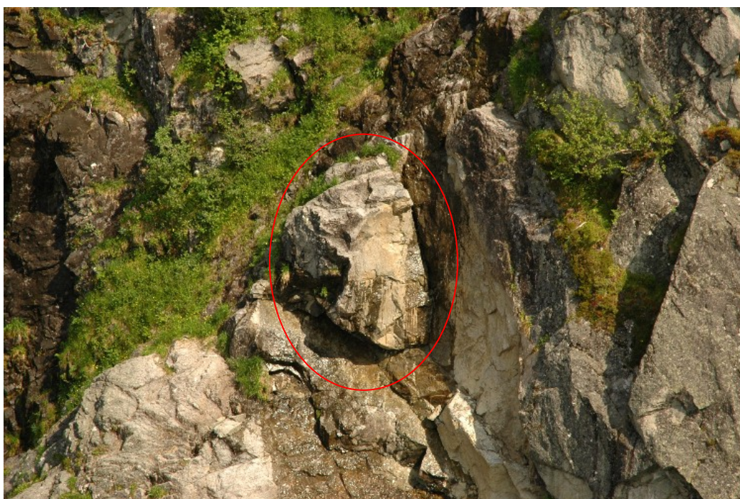
Figur 10: D2-1 før sprengning (foto: Multiconsult)
