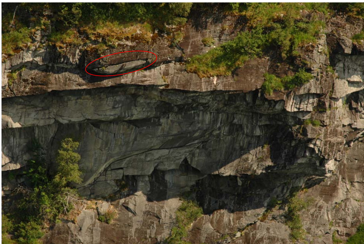
Figur 2: C5-1, før sprengning (foto: Multiconsult)
