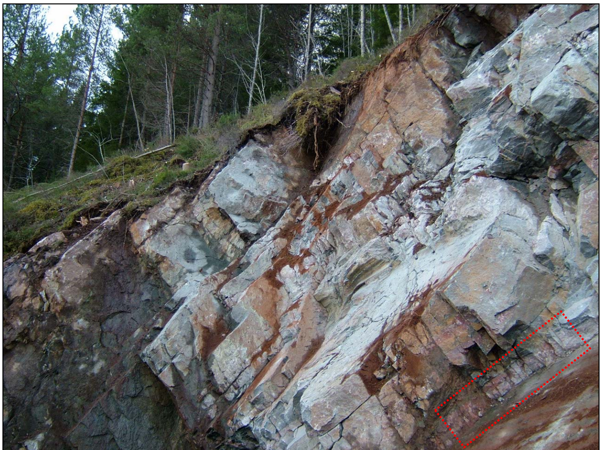
Figur 7: Foto tatt mot vest ved forskjæring som er under utsprengning ved profil ca 7140. Innfelt vises foliasjon parallell sprekkeflate med leirmateriale
