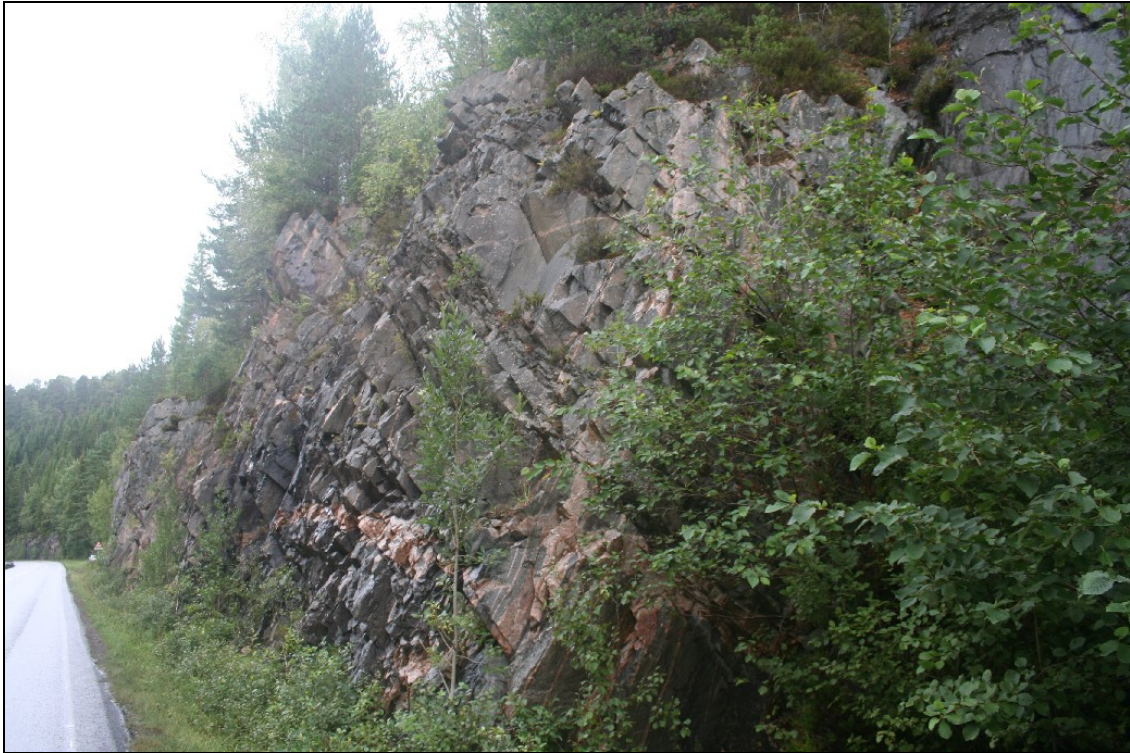
Figur 5: Foto tatt mot vest i Djupdalen ved ca profil 7040. Sprekkesett 2 dominerer.
