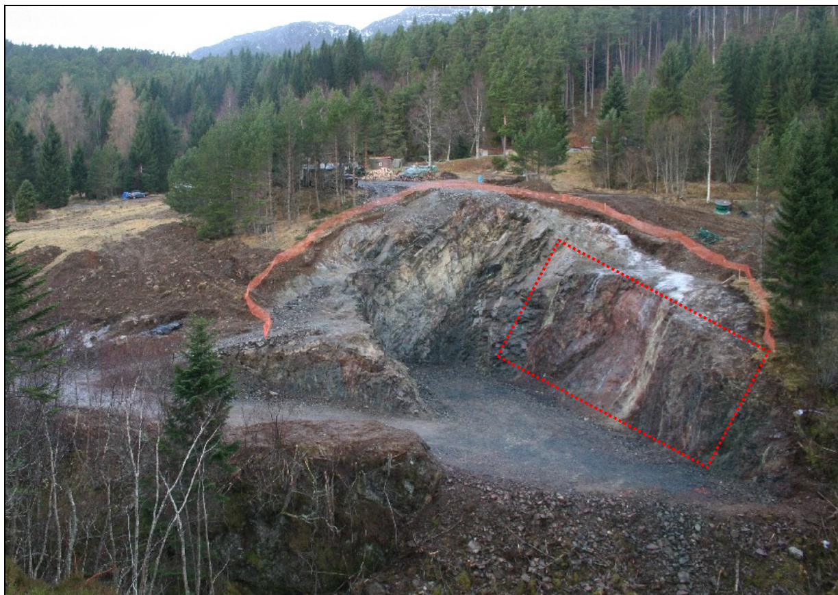
Figur 8: Foto tatt mot nord mot ferdig utsprengt forskjæring ved profil ca 7545. Innfelt vises bergmasse som ligger inn mot forkastningssonen ved Haukabølva, hvor det er observert leirholdig sleppemateriale som det er tatt prøve av.
