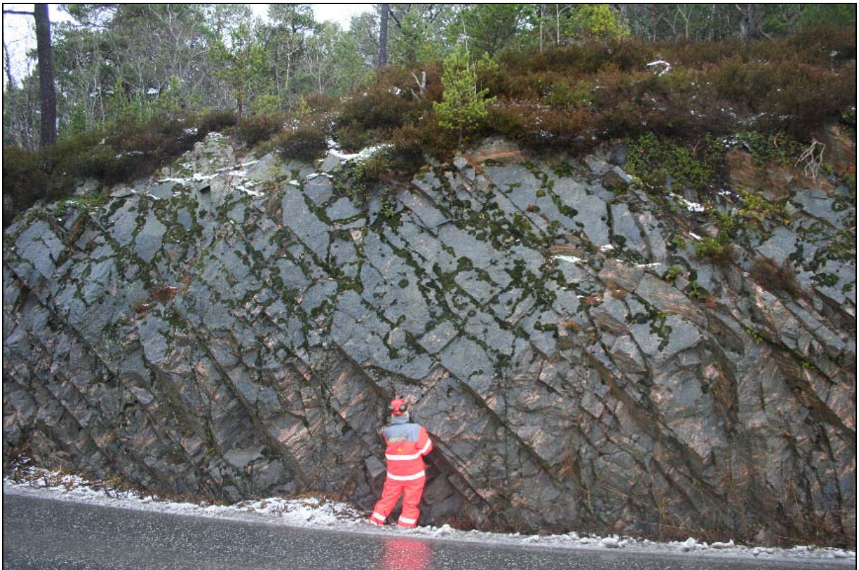
Figur 6: Foto tatt mot nord ved vegskjæring langs eksisterende Rv. 662. Sprekkesett 3 dominerer.
