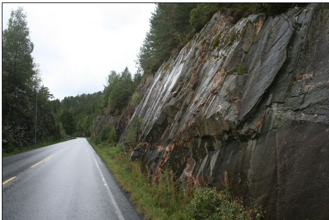
Figur 4: Foto tatt mot vest i Djupdalen ved ca profil 7010. Sprekkeseett 1 parallelt bergartens foliasjon dominerer.
