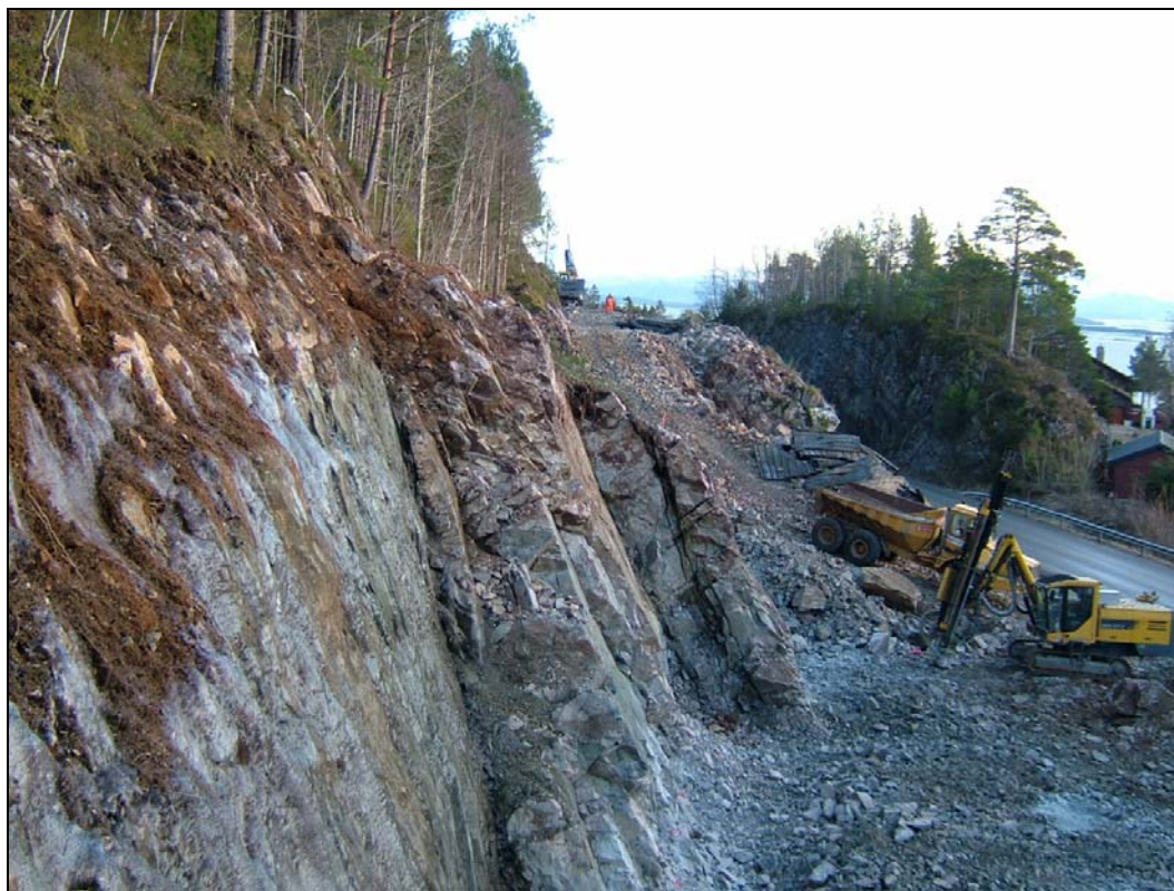
Figur 10: De foliasjonsparallelle bergsprekkene (sprekkesett 1) er generelt plane, ru, veldefinerte og glimmerholdige.
